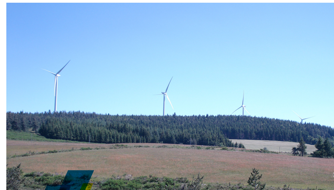
Parc éolien des Sources de la Loire (07)
